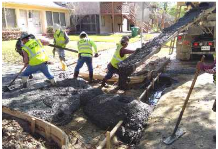
Driveway Concrete Pour
