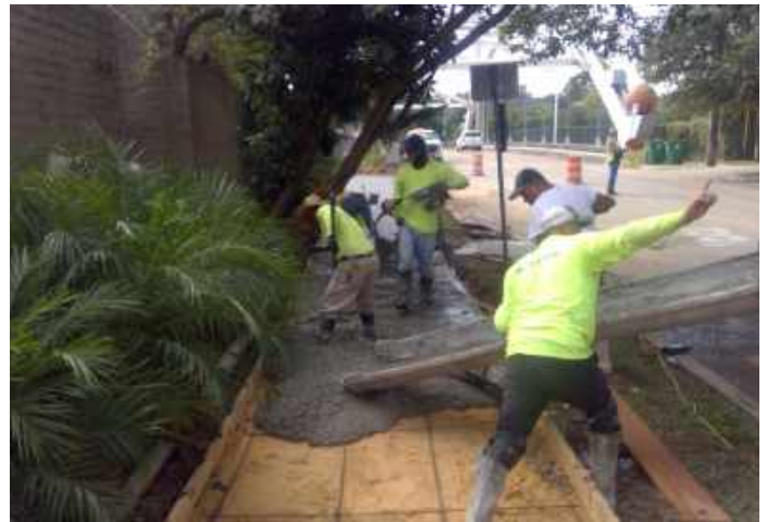
Sidewalk Concrete Pour
