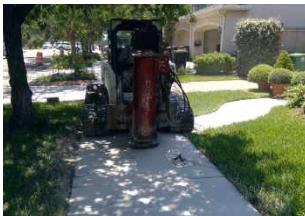
Sidewalk replacement (punchlist item)
