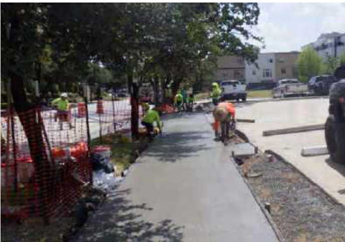
Sidewalk Concrete Pour
