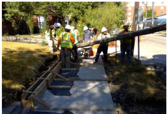
Curb Wall Concrete Pour
