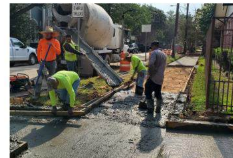
Sidewalk Concrete Pour
