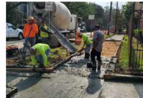
Sidewalk Concrete Pour
