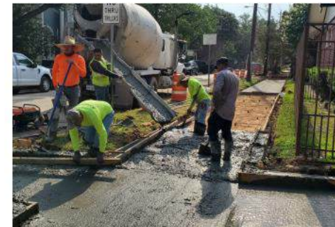
Sidewalk Concrete Pour
